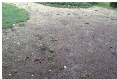
Cours constituées de graves hydrauliques
